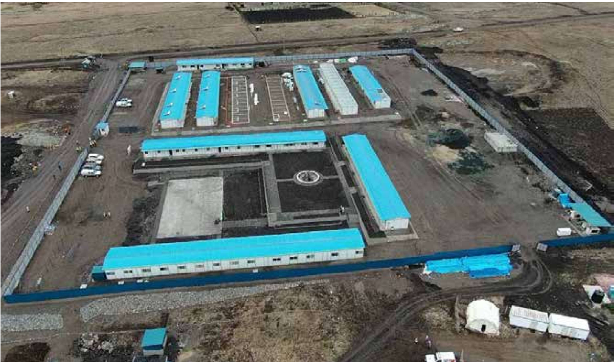
肯尼亚基佩托风电项目 Kipeto wind Farm Project in Kenya
