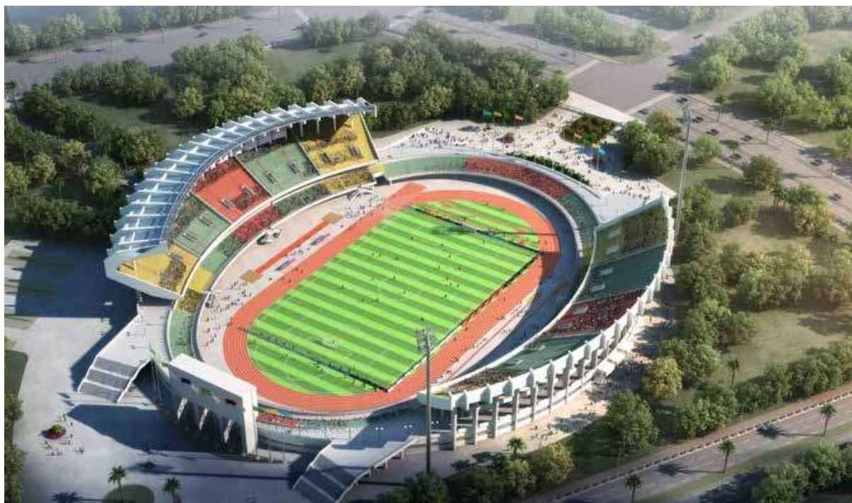
援多哥体育场维修项目 Aid Togo Stadium Maintenance Project
