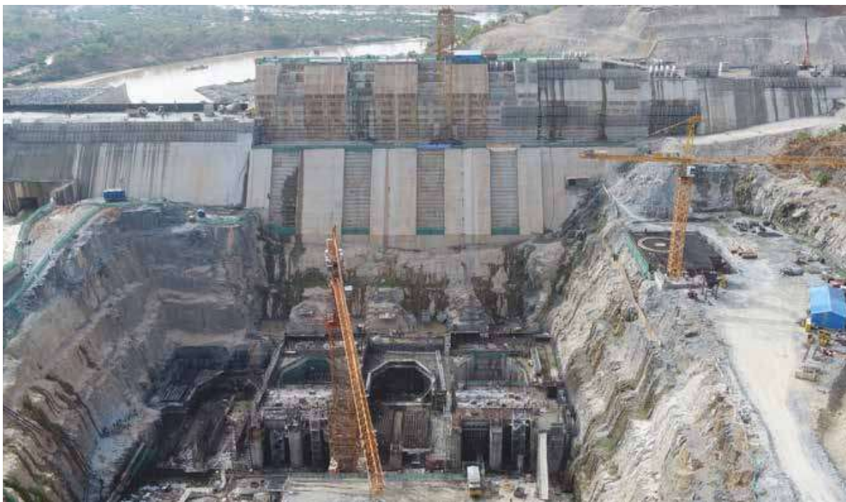
尼日利亚宗格鲁 700MW 水电站工程 700MW Zungeru Hydroelectric Power Project in Nigeria
