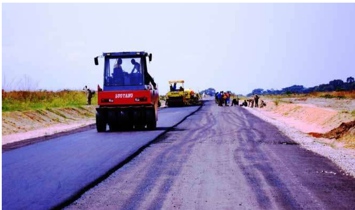
刚果（布）欧布亚 - 布昂吉 - 欧科伊欧公路改造及沥青铺设工程 Road Obouya- Boundji- Okoyo Project in the Republic of Congo
