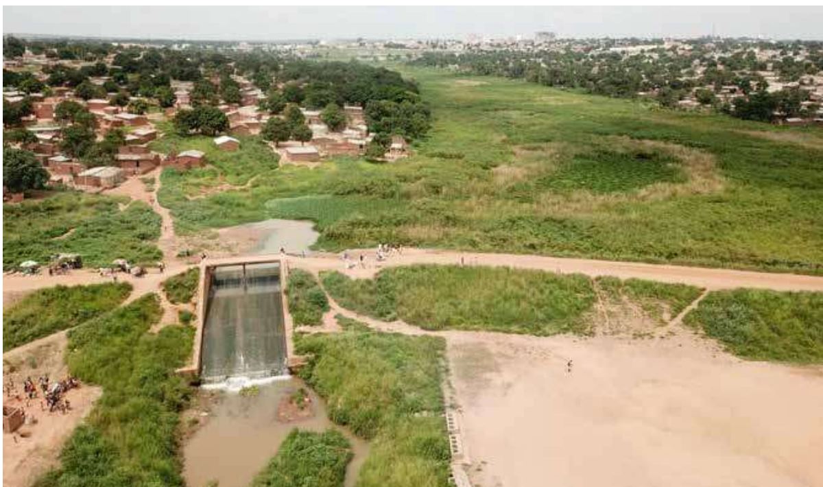
安哥拉马兰热河流疏浚项目 Malanje River Sanitation Project in Angola
