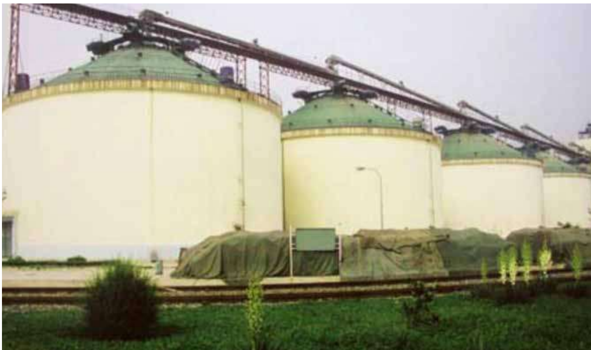
赞比亚粮仓项目（一期） Grain Storage Shed Project (Phase I) in Zambia
