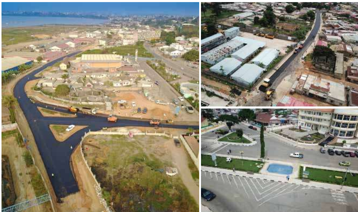
安哥拉卡宾达基础设施建设项目 Infrastructure Construction Project in Cabinda, Angola
