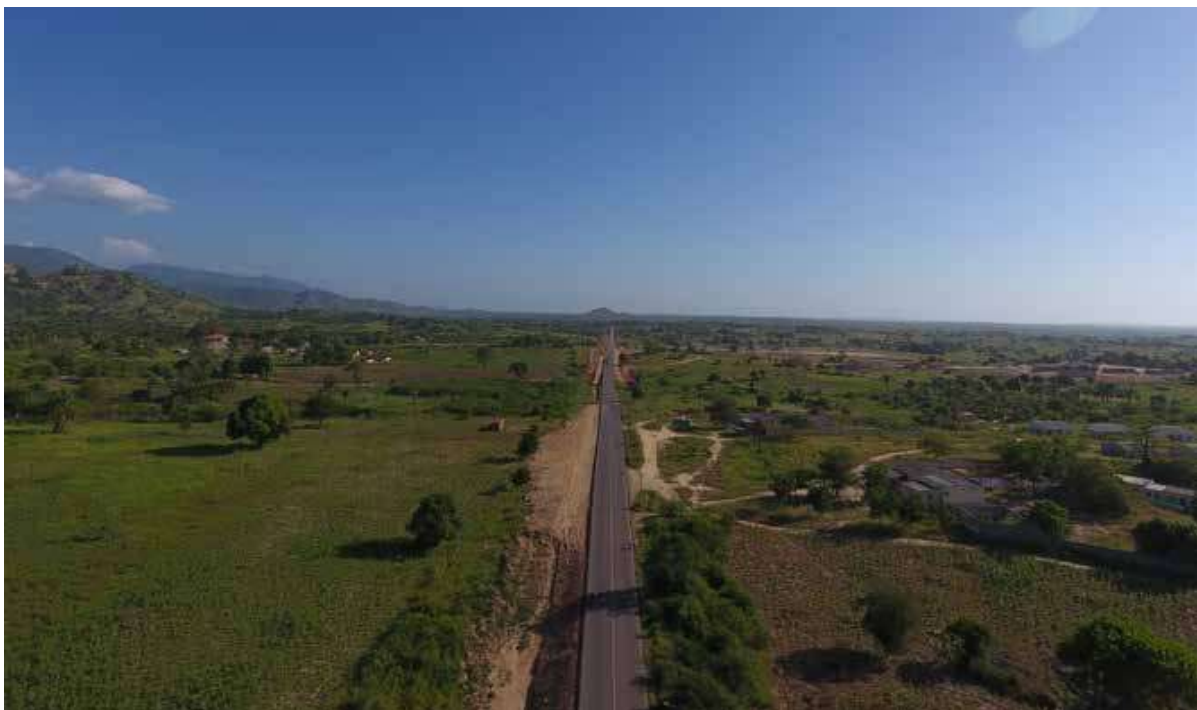
安哥拉四条道路修复项目 Four Road Repair Projects in Angola
