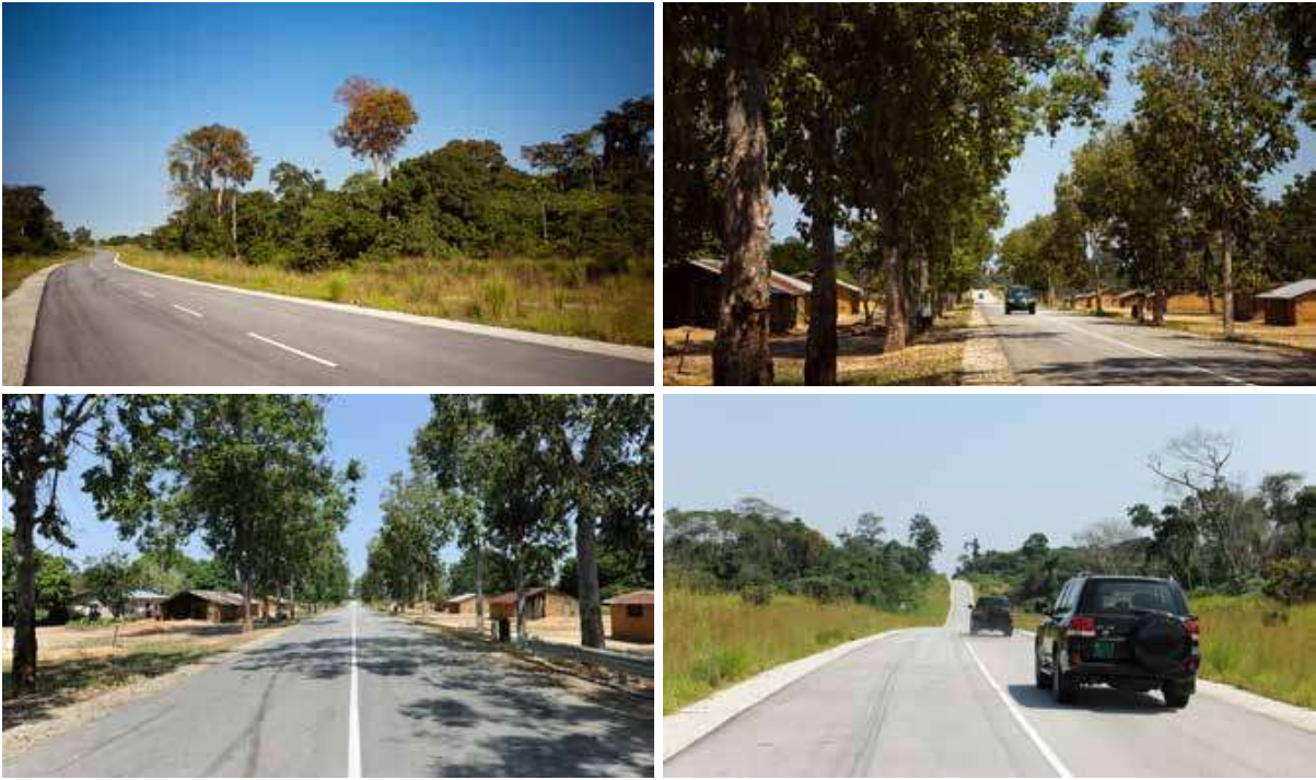
刚果（布）欧科约 - 雷科提 - 加蓬边境公路整治及沥青铺设项目 Road Obouy-lekety-frontiere Gabon Project in the Republic of Congo
