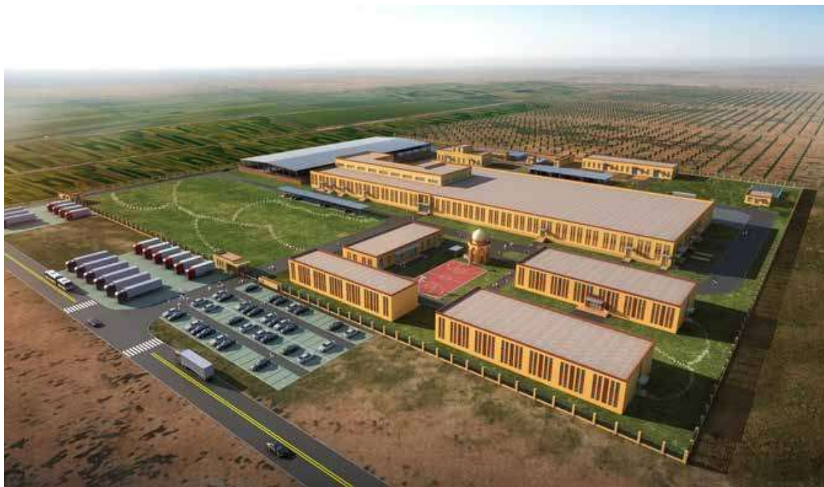
援苏丹屠宰厂项目 Aid Sudanese slaughterhouse project
