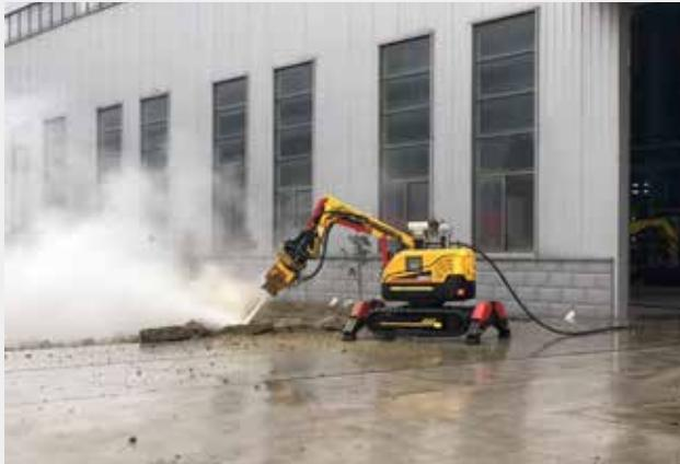
超高压水力破拆机器人
