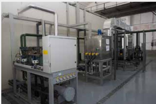
换热器性能试验装置
