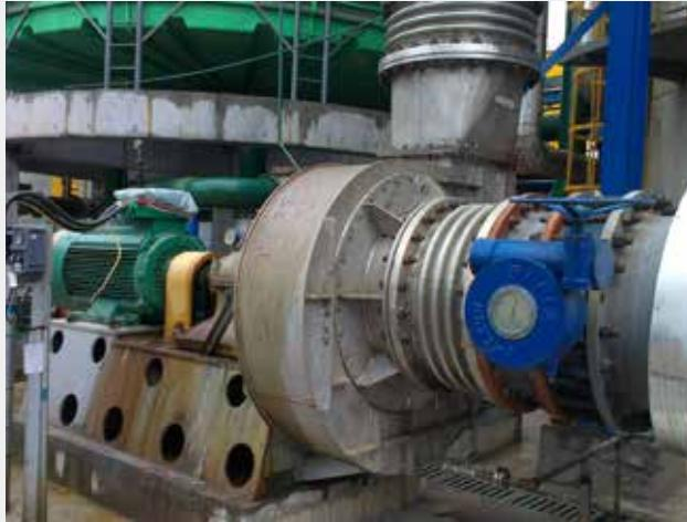
MVR 系统蒸汽压缩机
