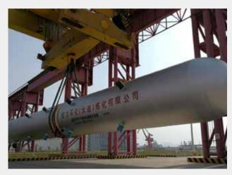
浙江石化 500 万吨 / 年渣油加氢装置渣油加氢反应器 Residuum hydrogenation reactor with a capacity of 5 million tons/year
