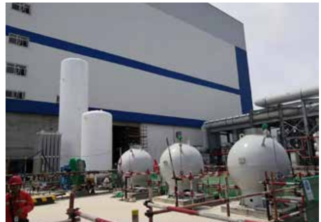
福清核电厂 5、6 号机组 ZA 厂房厂用气体存储及分配系统 ZA Gas Storage and Distribution System for Fuqing NPP Unit 5 and 6
