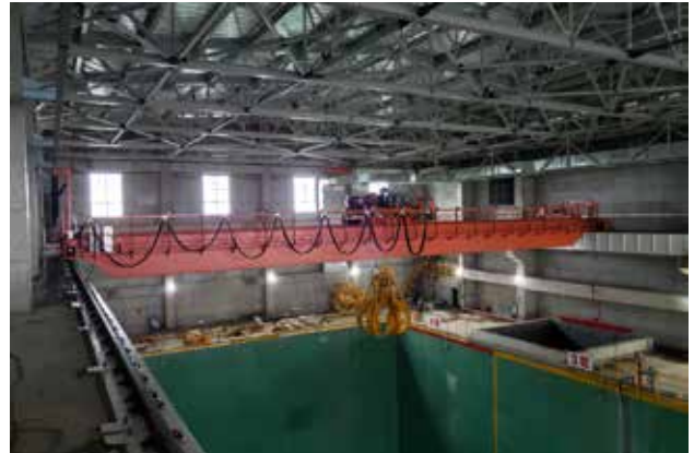
德阳市生活垃圾焚烧发电项目—高级半自动垃圾抓斗起重机 （全进口配置） Waste-to-Energy Project in Deyang, China—High Level Semi-auto bridge crane
