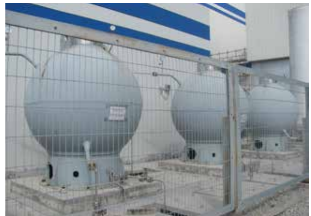
福清核电厂 1、2、3、4 号机组 ZA 厂房厂用气体存储及分配系统 ZA Auxiliary Gas Storage and Distribution System for Fuqing NPP Unit 1, 2, 3 and 4
