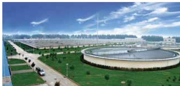
张家口宣化区羊坊水处理工程，污水处理 10.62 万吨 / 日， 污泥处理 97.5 吨 / 日 District Yangfang Water Treatment Project, Zhangjiakou Sewage treatment is 106,200 t/d, Sludge treatment 97.5 t/d
